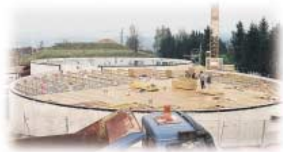
Neubau eines Hochbehälters
